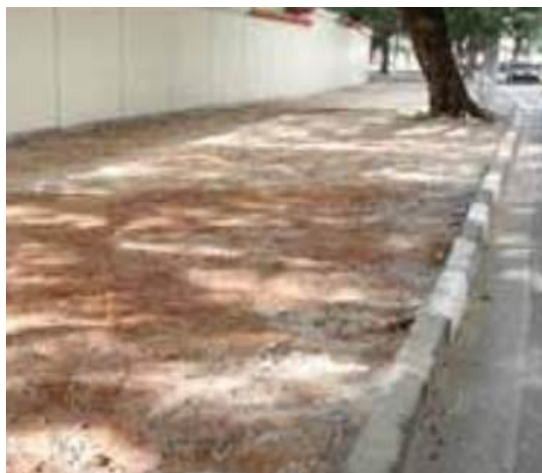
Figura 03 – Nivelamento e compactação do terreno
