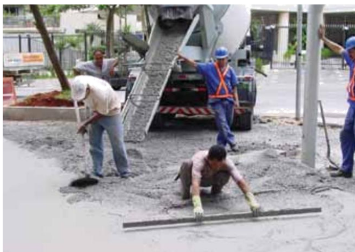
Figura 6 – Recebimento e espalhamento do concreto
