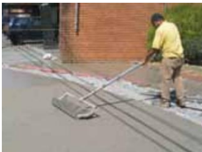
Figura 8 – rolo rebaixador de concreto
