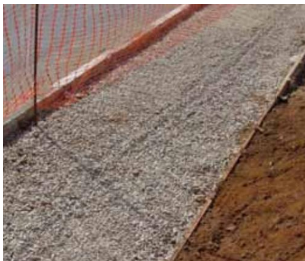
Figura 3 – Nivelamento e compactação do terreno
