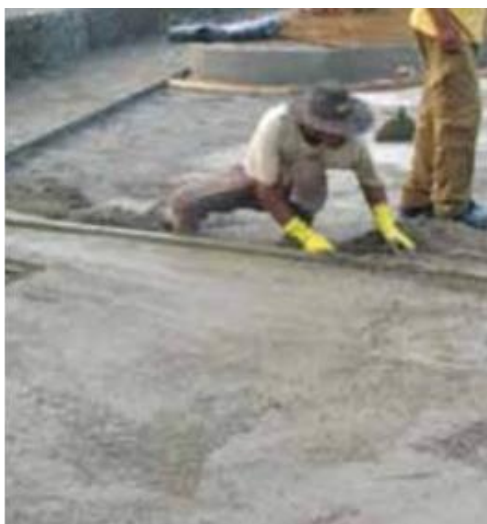
Figura 06 – Sarrafeamento do concreto.
