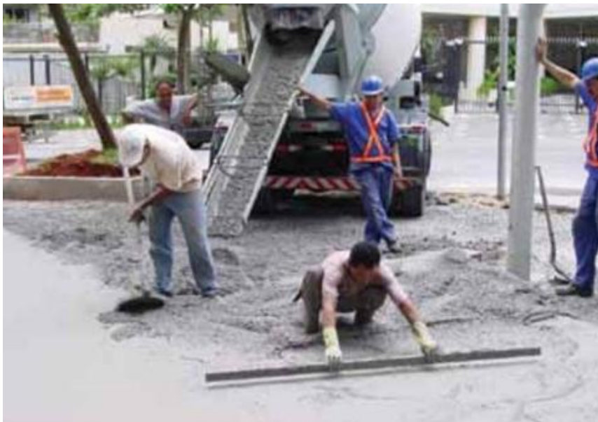
Figura 05 – Recebimento e espalhamento do concreto.
