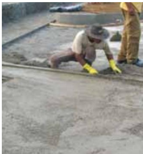
Figura 7 – Sarrafeamento do concreto
