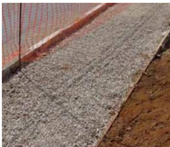
Figura 04 – Espalhamento da camada de Brita
