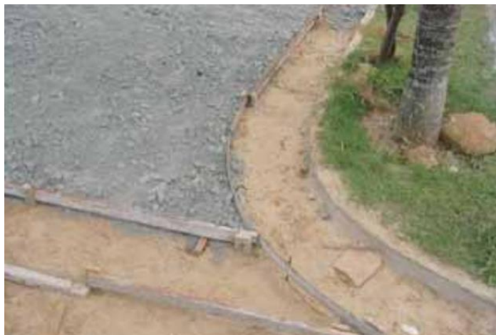
Figura 5 – Fixação das formas de madeiras
